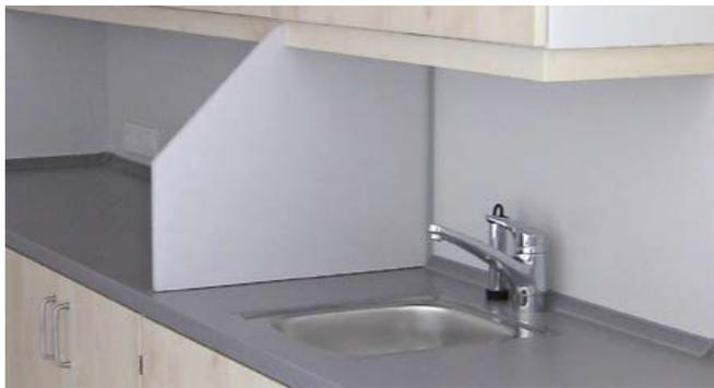
HPL-Arbeitsplatte mit flächenbündig eingebauter Edelstahlspüle
